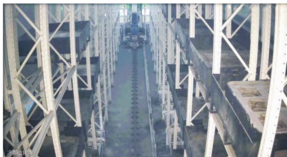
图2 芯包存储立体库
