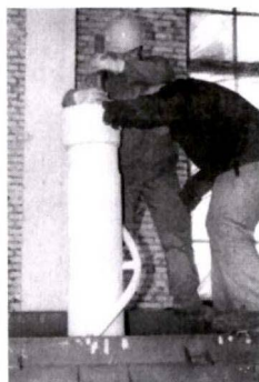
图3 筒内腔插真空管
