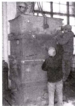
图5 第3节砂箱加砂
